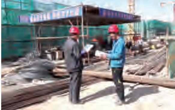
عمال في موقع بناء بالصين
