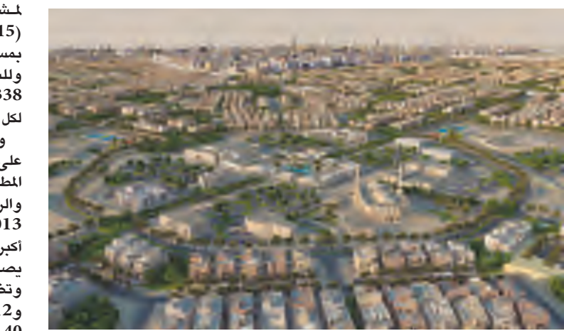
مشروع (جنوب المطلاع) الإسكاني
