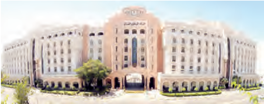
مقر البنك المركزي العماني
