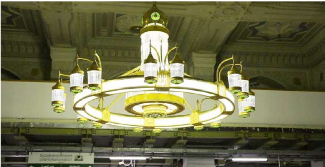
إحدى وحدات الإنارة في المسجد الحرام
