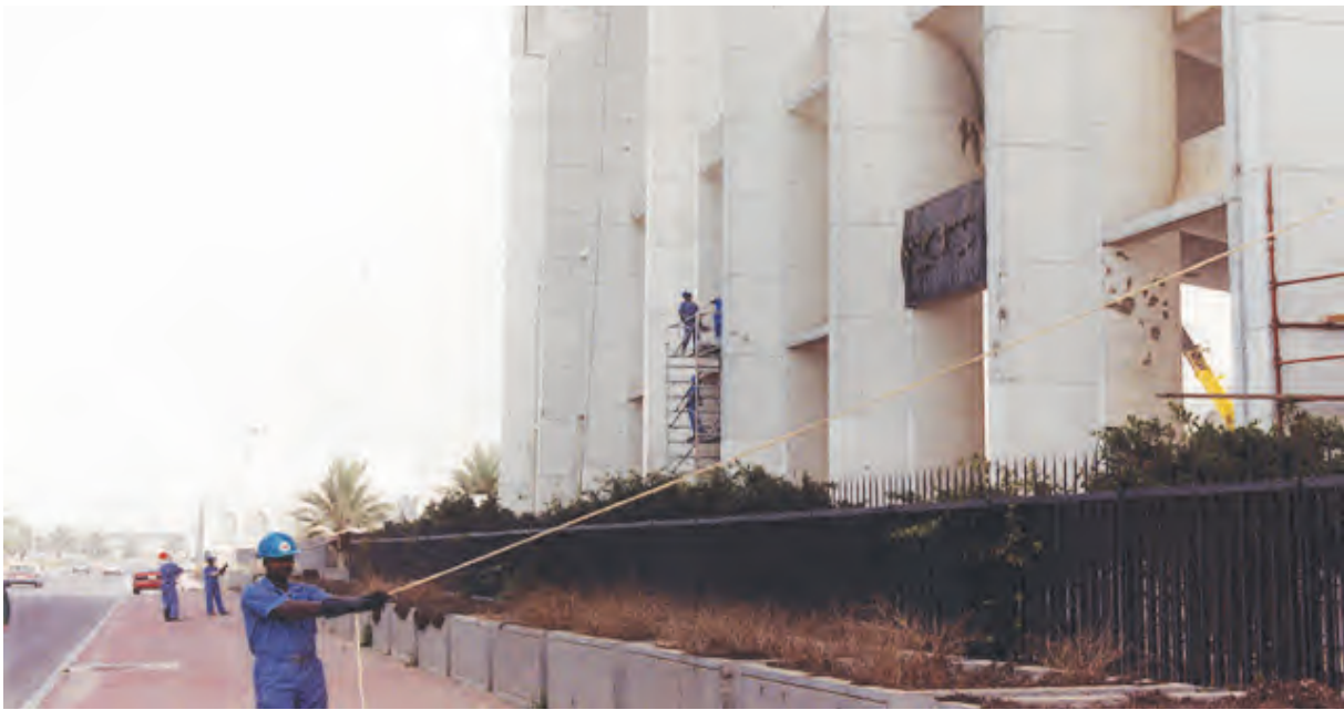
جانب آخر من أعمال ترميم مبنى مجلس الأمة
