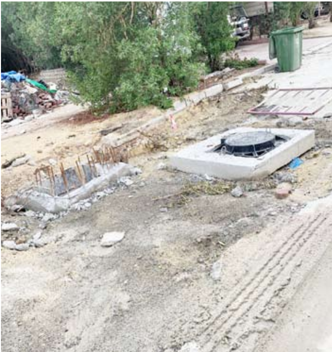
أعمال ترميم بطيئة أمام المنازل بالصباحية
