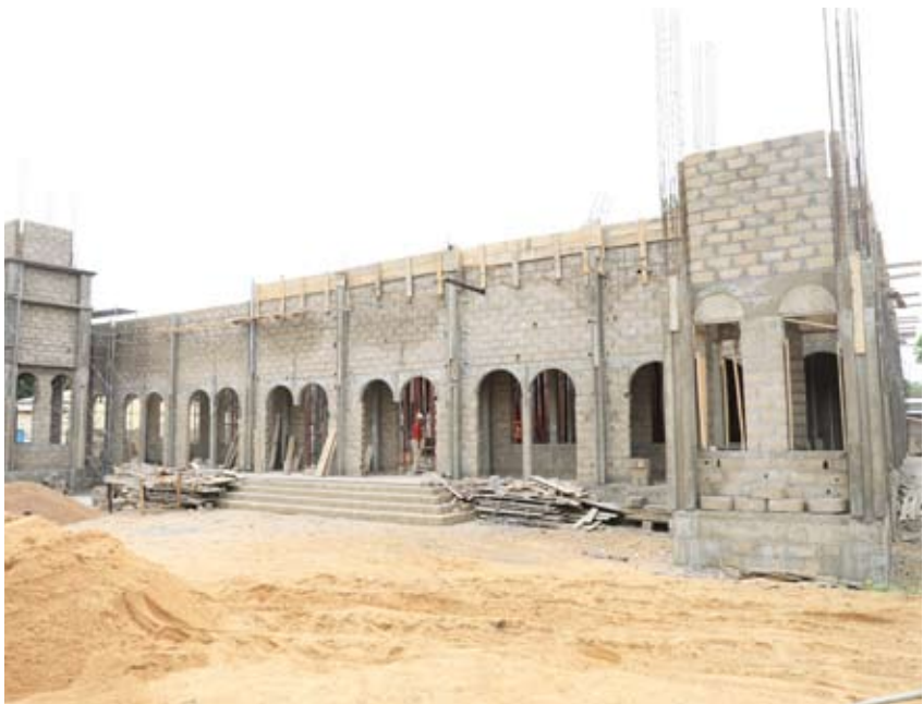
مسجد تحت البناء
