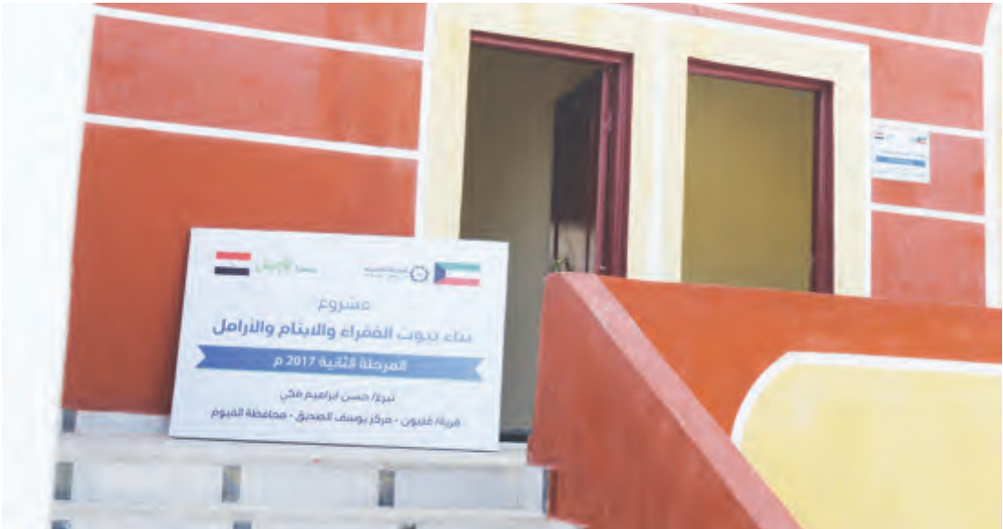
مشروع بناء بيوت الفقراء والإيتام والأرامل
