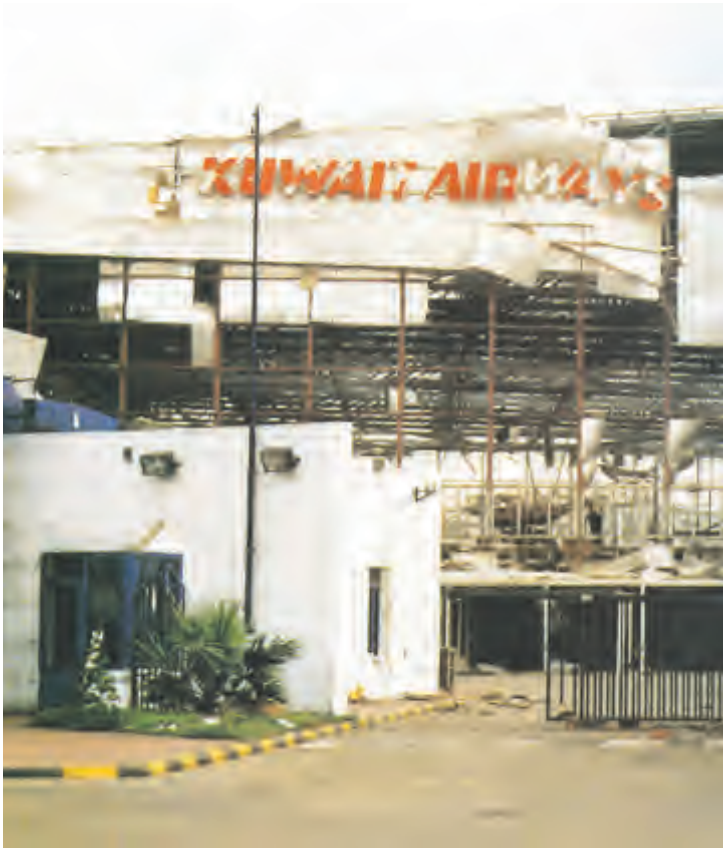
مبنى مطار الكويت
