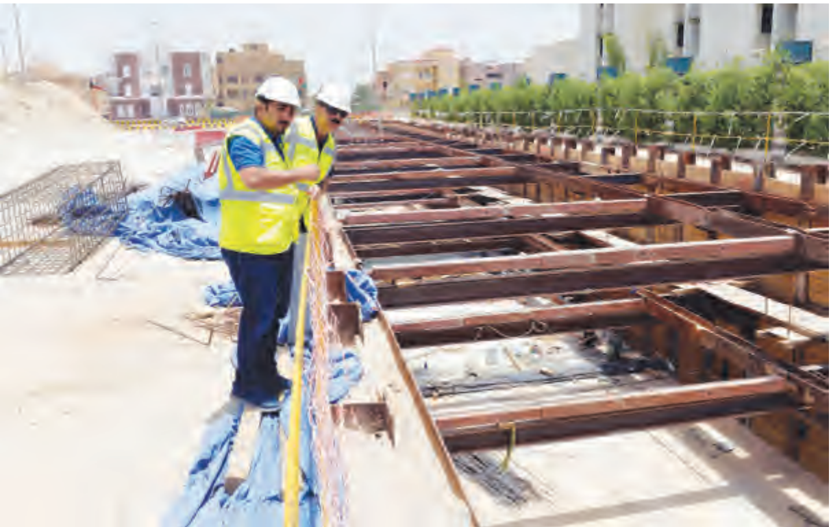
جانب من أعمال المشروع
