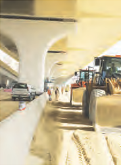
أعمال الرصف مستمرة
