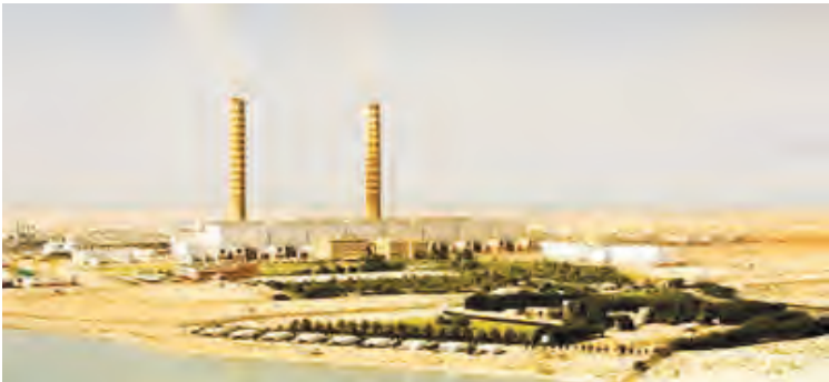
محطة الدوحة الكهربائية
