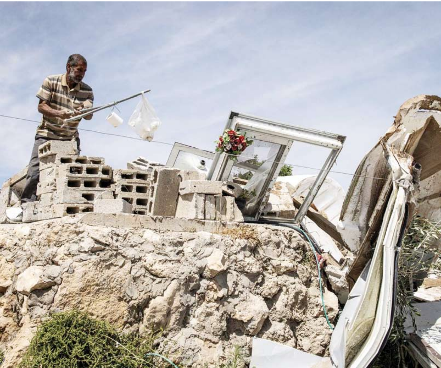
فلسطيني يجمع أغراضاً من انقاض منزل مهدم
