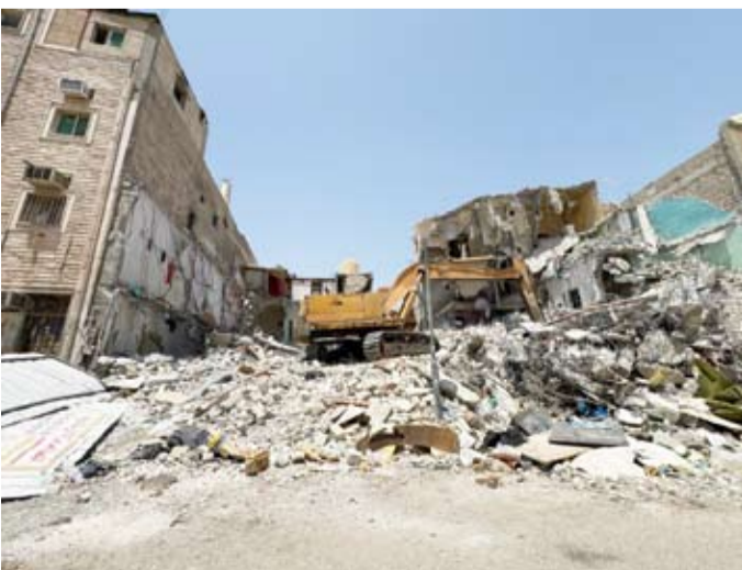
جانب من عملية الهدم
