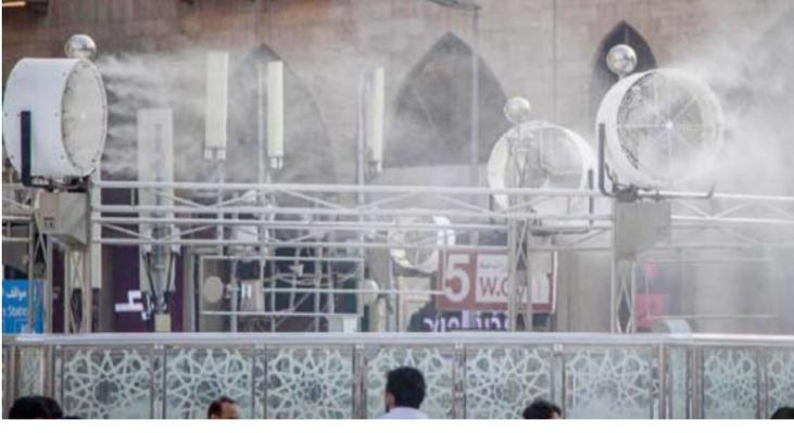
وفرت الرئاسة العامة لشؤون المسجد الحرام والمسجد النبوي، ممثلة في وكالة الشؤون الفنية والتشغيلية والصيانة 242 مروحة رذاذ، و 216 عمود ضباب مائي لتلطيف أجواء ساحات المسجد الحرام باستخدام تكنولوجيا (تبريد الهواء بالرذاذ) من خلال امتصاص الطاقة الحرارية من الهواء الخارجي وخفض درجة حرارته لدرجة تقارب (6) درجات مئوية.
