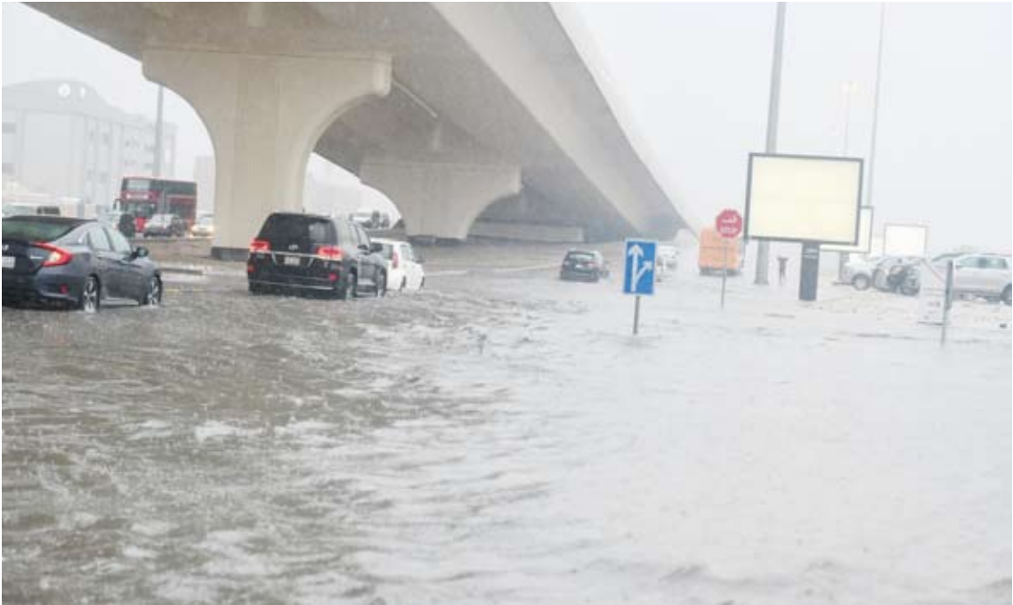
تجمع مياه الأمطار التي لم تستوعبها شبكة صرف الأمطار
