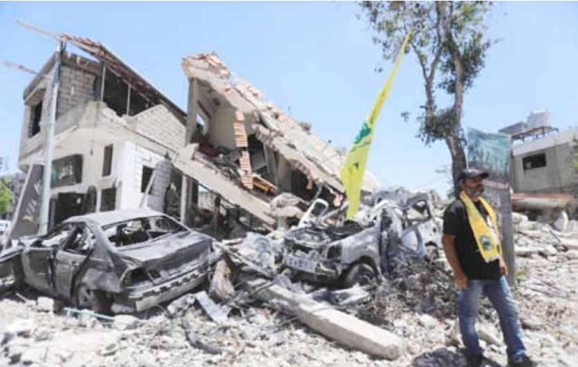
البناني التي دمرت أثناء القصف الصهيوني
