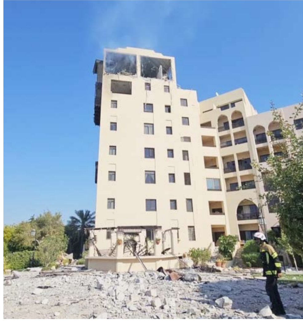
أضرار مادية في مبنى سكني بمحافظة المحرق البحرينية
