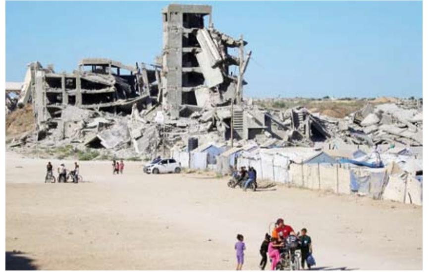
مبنى متضرر بشدة في مخيم النصاريا للاجئين
