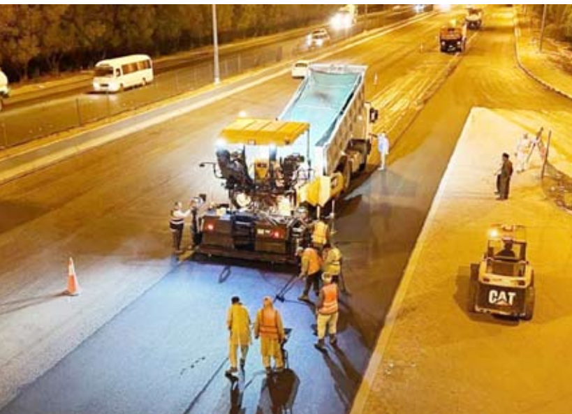
جانب من اعمال رصف طريق الجهراء
