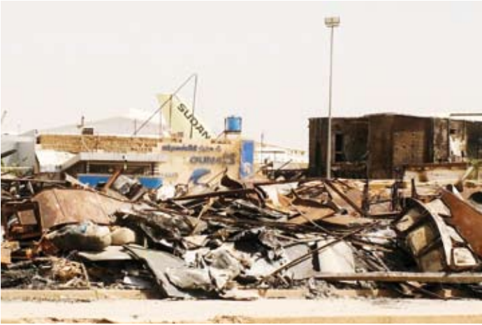
مبنى محترق في مطار الخرطوم
