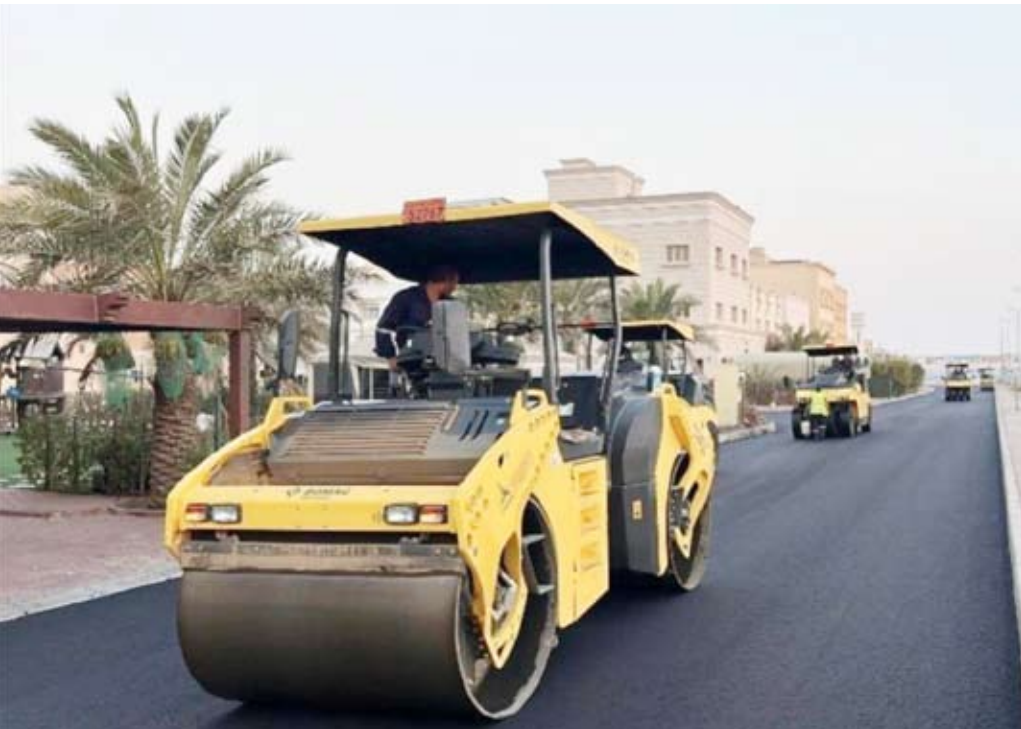
معالجة طبقات الأسفلت المتضررة وإعادة تأهيل الطرق
