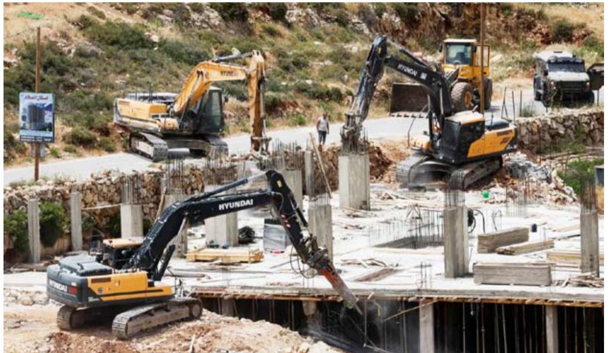
آليات ثقيلة تهدم مبنى فلسطينياً قرب بيت لحم
