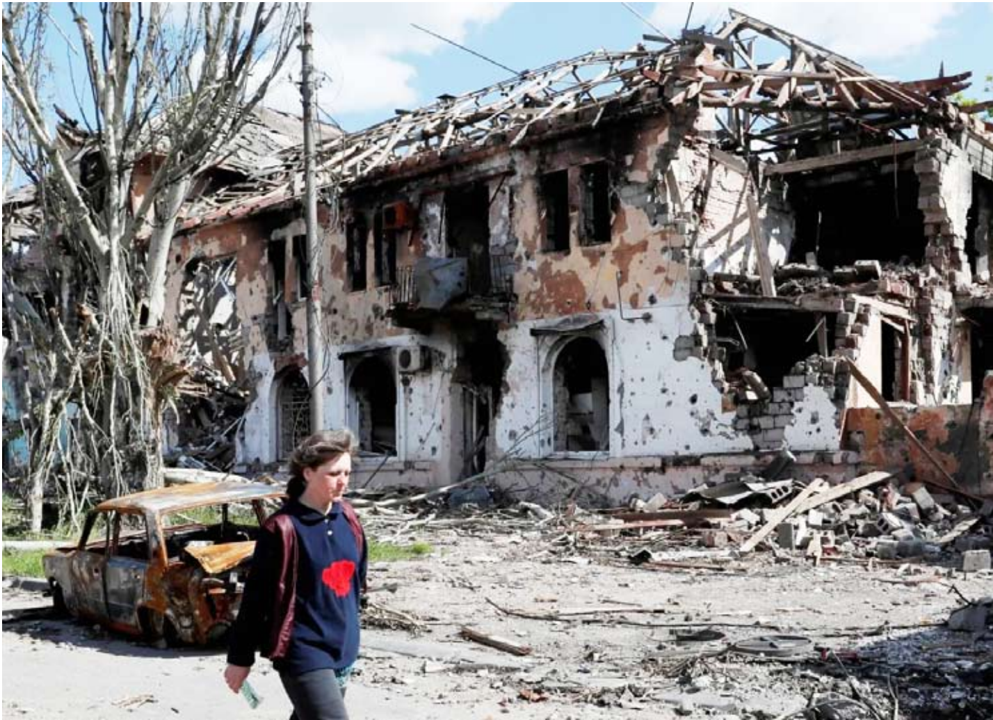
المباني المتضررة جراء ضربات روسية في بلدة كوستيانتينيفكا
