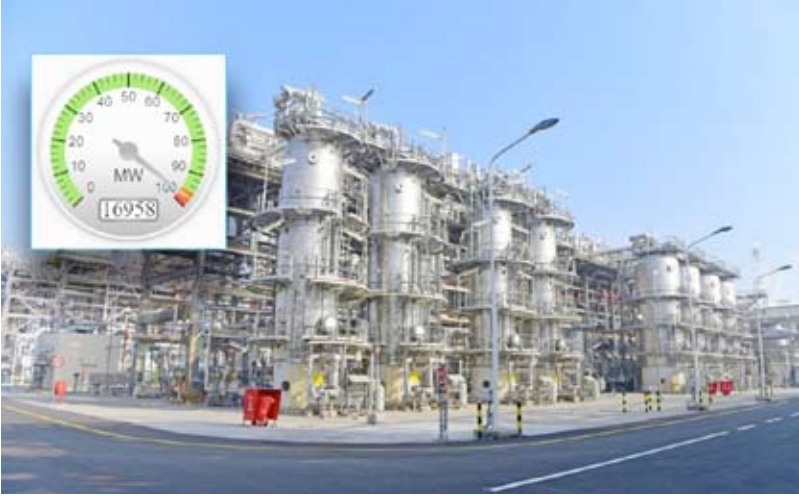
محطة كهرباء الزور
