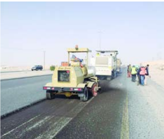
جانب من أعمال صيانة الطرق
