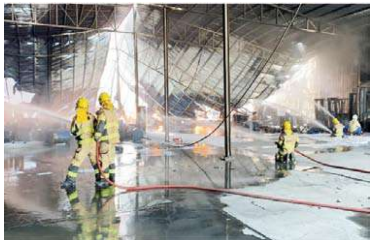
رجال الإطفاء سيطروا على الحريق قبل امتداده لمصانع مجاورة
