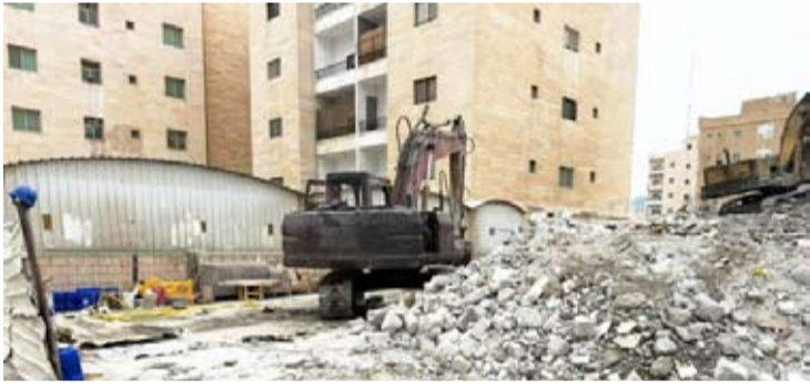
هدم المباني المخالفة
