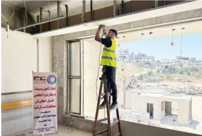
جانب من بدء إعادة بناء وترميم المركز شمال قطاع غزة
