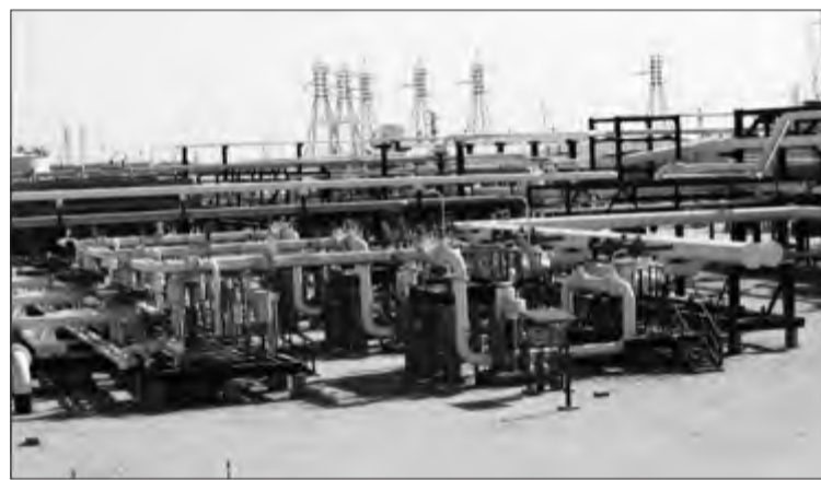
لقطة عامة لأنابيب نفط في حقل الشراة النفطي
