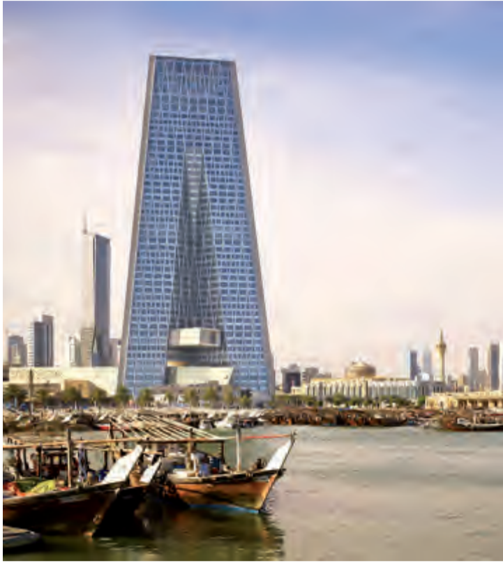
مقر البنك المركزي
