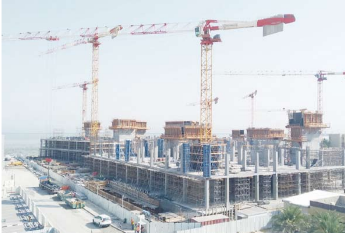
الانتهاء من الحفر ووضع أساسات المبنى
