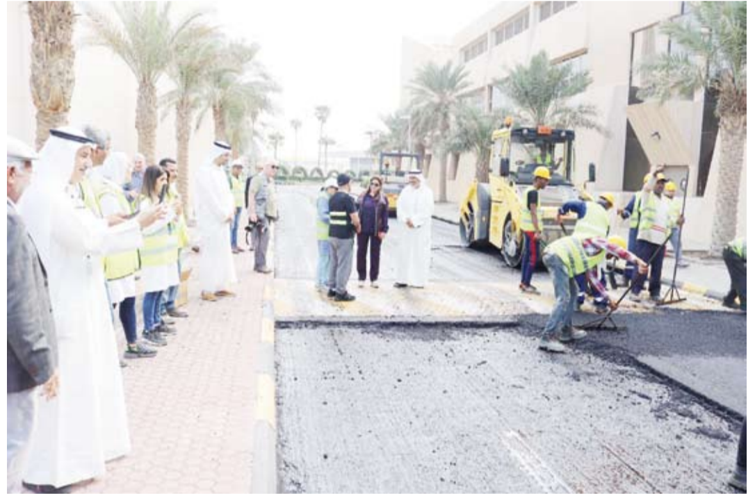
جانب من عملية التنفيذ لتطبيق تقنية الأسفلت المطاطي
