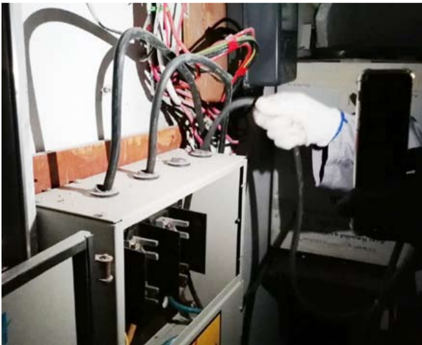
قطع التيار الكهربائي
