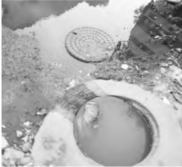
فتح مناهيل صرف مياه الأمطار
